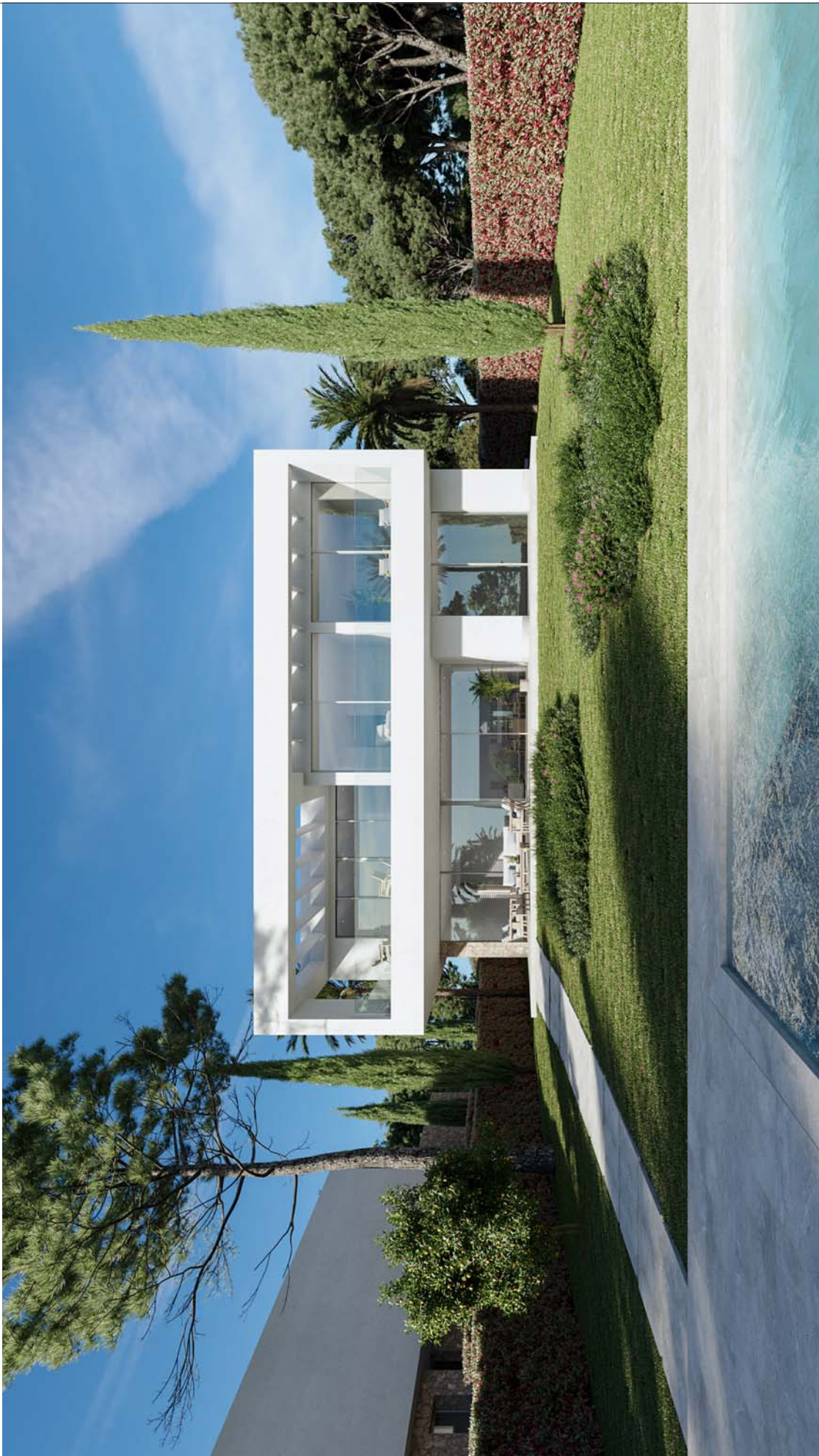
VIVIENDA CARRER COSTA DE CALVIÀ 3
